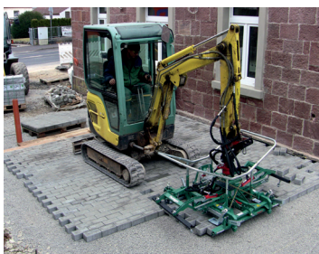
Pe mini-excavatoare în șantier mici
